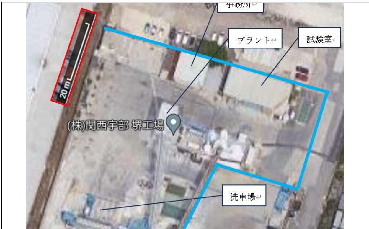
図3.2 関西宇部 堺工場敷地(240127 提供写真。ポンプ車配置や配管計画は図3.3)
